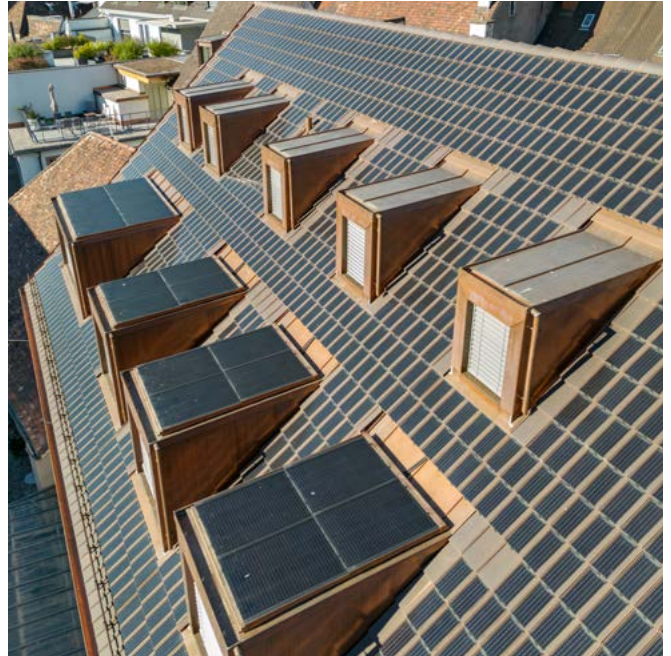
Auf den handelsüblichen Tondachziegeln sind kleine Photovoltaikmodule befestigt. So lassen sich Energieproduktion und Ästhetik in Einklang bringen. (Fotos: Gasser Ceramic)
