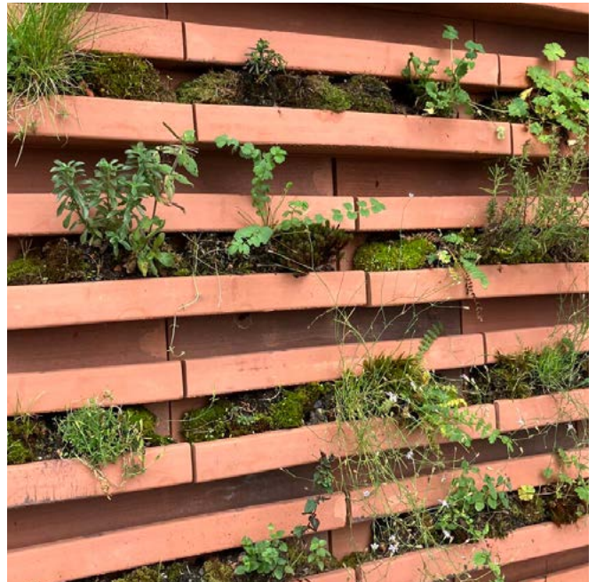
Begrünte Fassaden mit einer keramischen Tragstruktur fördern die Biodiversität und halten im Sinne der Schwammstadt Regenwasser zurück. (Foto: Zürcher Ziegeleien AG)
