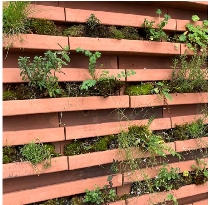
Les façades végétalisées avec une structure porteuse en céramique favorisent la biodiversité et retiennent les eaux pluviales à la manière d'une ville éponge. (Photo: Zürcher Ziegeleien AG)
