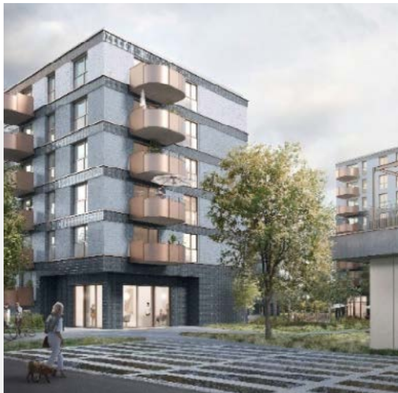
Hinter der eleganten Fassade steckt eine effiziente Bautechnik: Die Aussenwände wurden mit Fertigbauteilen aus Backstein erstellt. (Nightnurse Images AG)
