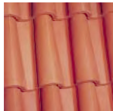
Pfannenziegel, Typ «Römerziegel» oder «Klosterziegel» Lattweite: ca. 35 cm Deckbreite: ca. 19 cm Ziegelbedarf: ca. 13 – 15 Stk./m 2
