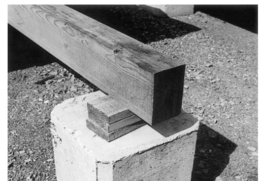
Bild 3: Beispiel für eine Unterlage, die für das Stapeln von Holz errichtet wurde
