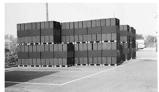
Bild 4: Deutlich signalisierter Lagerplatz
