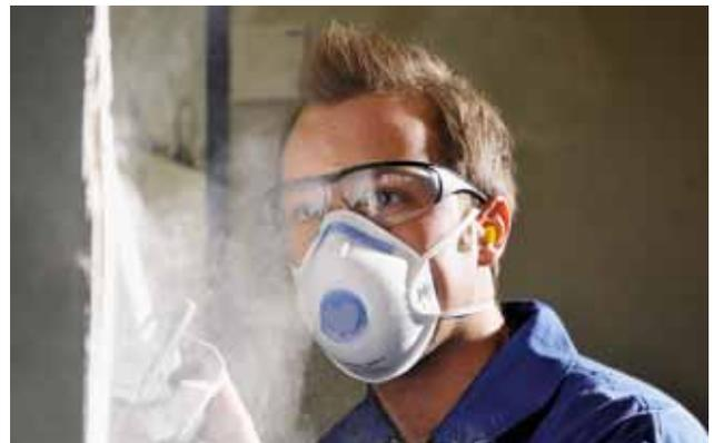
**Bild 4:** Masken der Filterklasse FFP2 bzw. P2 sind für viele Arbeiten der Standard.
