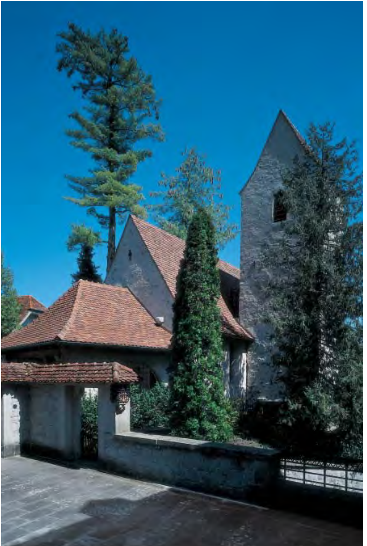
Kirchendach, Turm und Umfassungsmauer gedeckt mit «antiken» Biberschwanzziegeln
