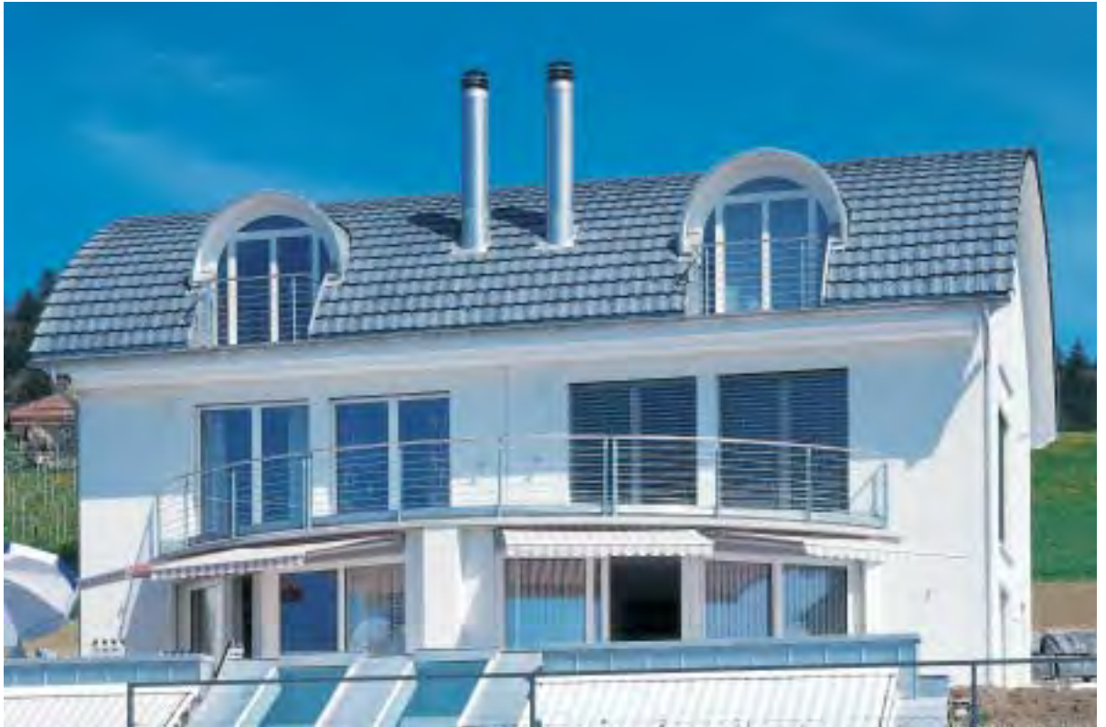
Tonnendach mit schiefergrauen Flachziegeln
