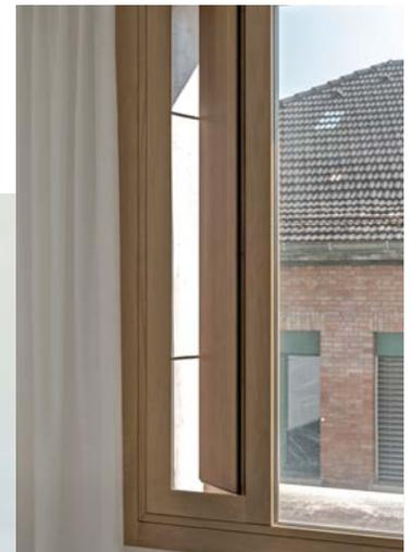
Die im Fenster eingebauten Lüftungsclappen sorgen sensorgesteuert für eine hohe Raumluftqualität.
