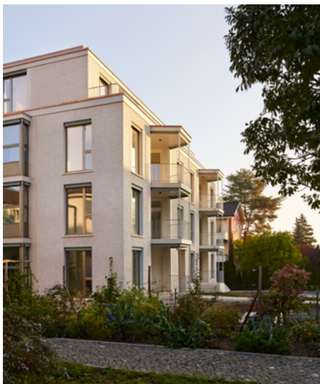
La maçonnerie en brique peut être recouverte d'un enduit qui forme une patine noble avec le temps. (Photo: Seraina Wirz)
