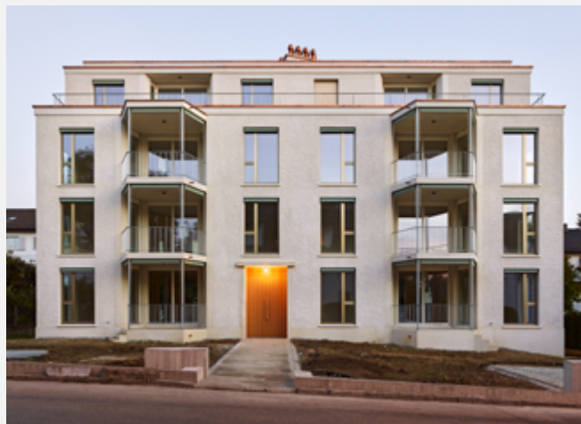
La maçonnerie en brique peut être recouverte d'un enduit qui forme une patine noble avec le temps. (Photo: Seraina Wirz)
