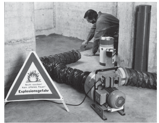
Bild 5: In Kellern ist eine künstliche Absaugung nötig. Bei Bedarf müssen tragbare Ventilatoren eingesetzt werden.
